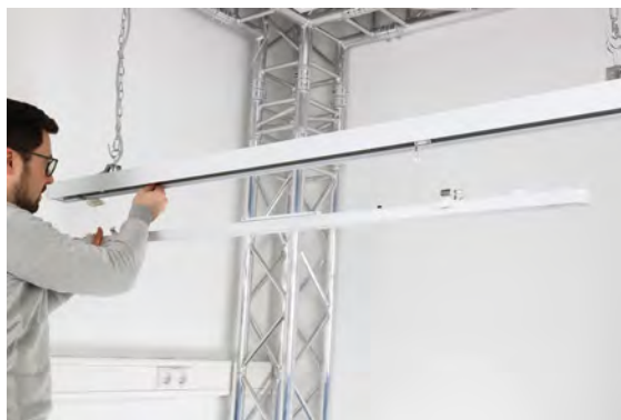
2 - accrocher les nouveaux modules LED dans l'ancien rail porteur
