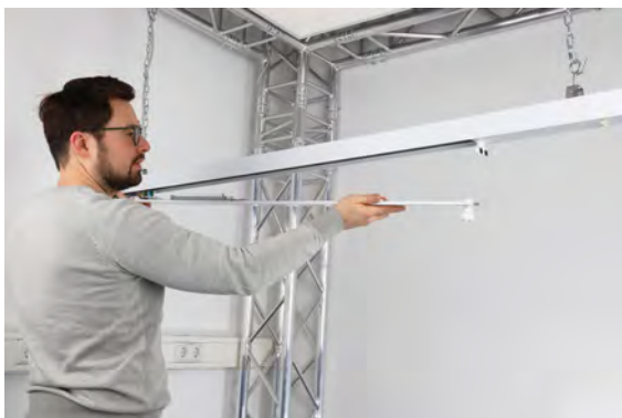
1 - enlever les anciens inserts de luminaires [le câblage reste en place]
